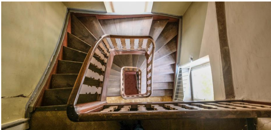
Treppe Bahnhofsgebäude Rottendorf
